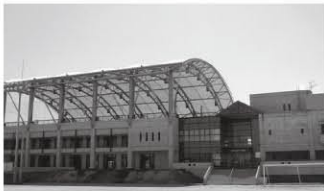
クラブハウス(成岩中学校敷地内)
